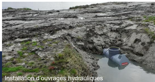
Installation d'ouvrages hydrauliques
