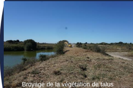
Broyage de la végétation de talus
